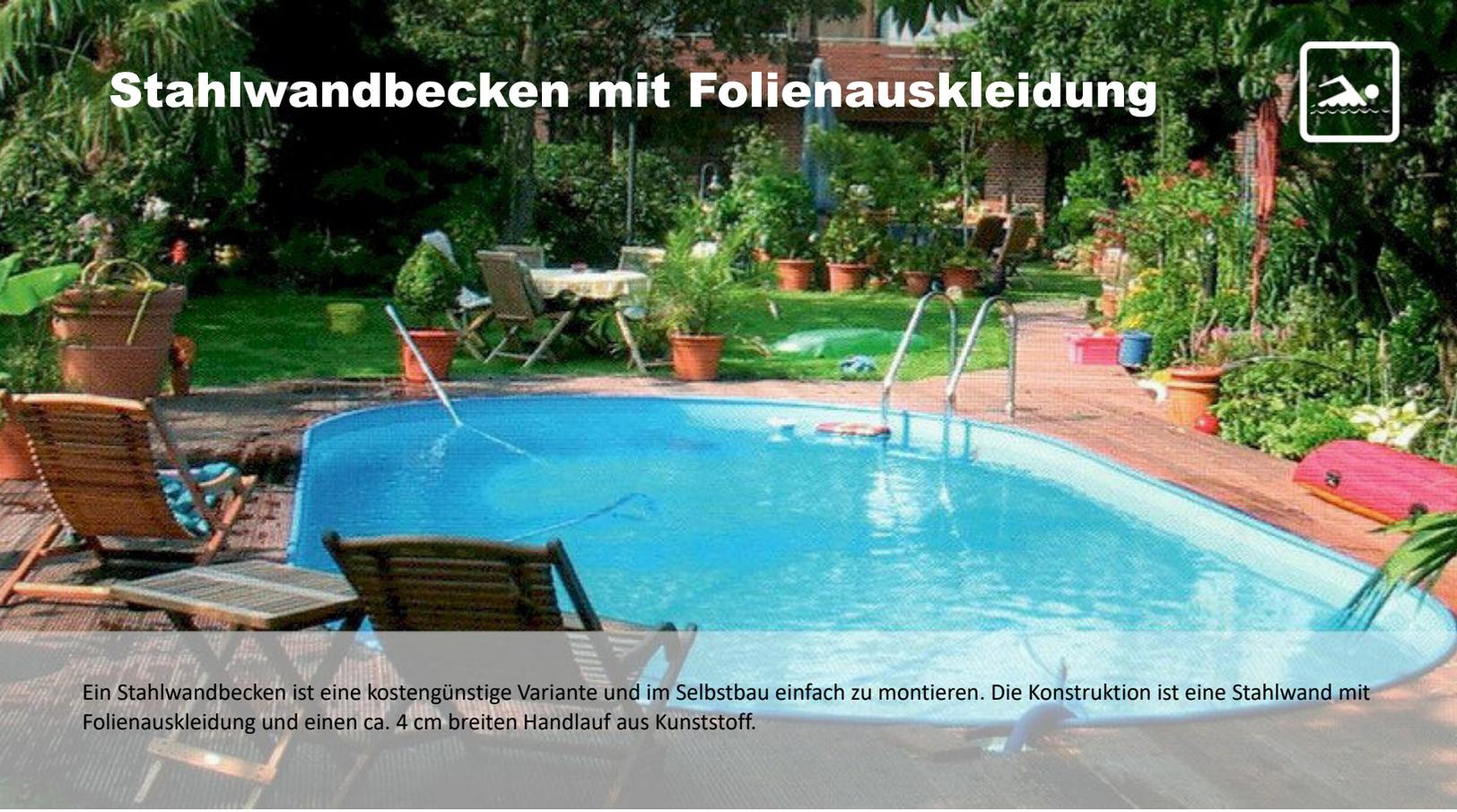
Ein Stahlwandbecken ist eine kostengünstige Variante und im Selbstbau einfach zu montieren. Die Konstruktion ist eine Stahlwand mit Folienauskleidung und einen ca. 4 cm breiten Handlauf aus Kunststoff.
