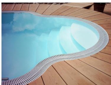
Die Vorteile eines Beckens mit Überlaufrinnen ist, dass die Wasseroberfläche in einer Ebene mit dem umgebenden Terrain ist. Es bilden sich keine Wellen, da das Wasser nicht von den Wänden zurückprallt. Eine effektive Umwälzung des Wassers garantiert kristallklares sauberes Wasser.
